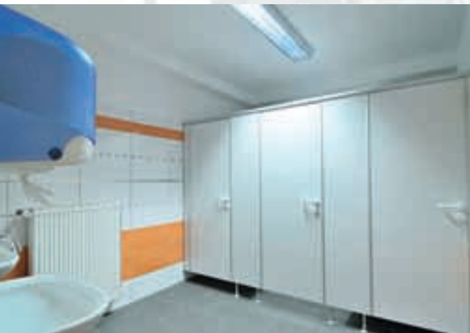
Im Frühjahr 2010 wurde die dringend notwendige Instandsetzung der sanitären Anlagen im Untergeschoss des Saalbaus in Angriff genommen
